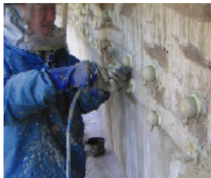
リフレフィルボンド注入状況
