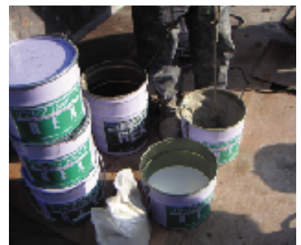
リフレフィルボンド混練状況
