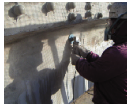
注入器具及びシール材撤去状況
