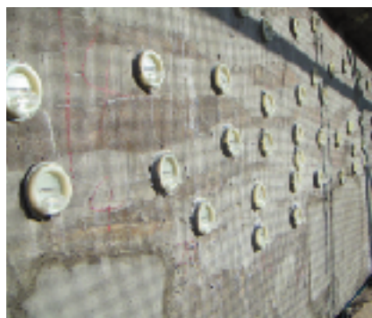
シール及び注入器具取付状況
