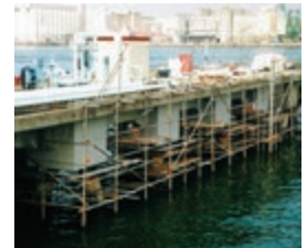
栈橋補修工事
