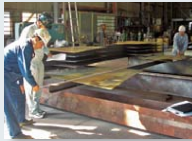
鋼製部材製作
