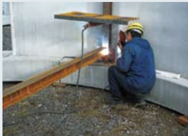
鋼製部材組立
