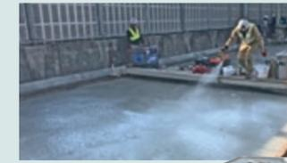
コンクリート表面の仕上げ性向上、初期乾燥の抑制に最適な被膜養生剤です。
