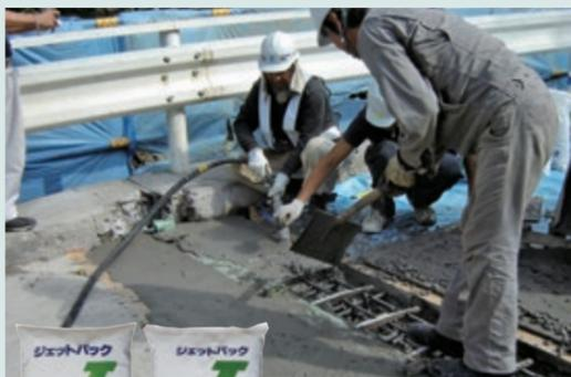
超速硬セメント、骨材、混和剤、凝結遅延剤、練混ぜ水が全て計量・包装済。現場でミキサーを用意するだけで、ジェットコンクリートが手軽に打設できます。
