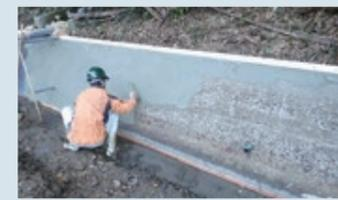
摩耗で劣化した農水路の表面被覆や断面修復に用いるポリマーセメント系補修材です。
