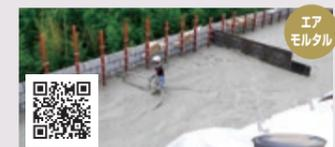
エアミルク・エアモルタルを用いた気泡混合軽量土（FCB）や気泡混合土用などに開発された高品位特殊界面活性剤系起泡剤です。
