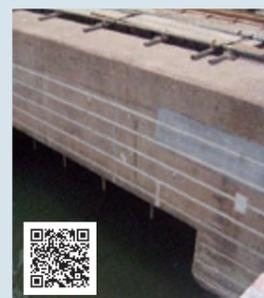
コンクリート表面に設置した陽極材(チタンリボンメッシュ陽極など)からコンクリート内部の鉄筋に防食電流を供給することで、鉄筋に生じる腐食電流の抑制を目的とした最も信頼性の高い防食工法です。
