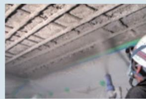
比重1.9程度の軽量性を有した吹付け施工性に優れたポリマーセメント系断面修復材です。
