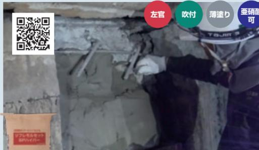
左官・吹付け可能な汎用・厚付け型ポリマーセメント系断面修復材です。塩害対策仕様で用いる亜硝酸リチウム(リフレα40)の混和も可能です。
