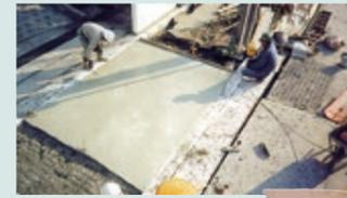
硬化時間が30分以上に調整された超速硬セメントです。
