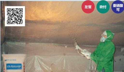
左官・吹付け可能な汎用型ポリマーセメント系断面修復材です。塩害対策仕様で用いる亜硝酸リチウム(リフレα40)の混和も可能です。
