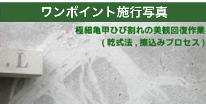
コンクリート製品の表面に発生した亀甲状のマイクロクラックに対し、Lタイプ(淡色)のスティックで被覆補修している所です。ひび割れ幅0.1mm程度ですが全面に発生、これを素早く美観回復する方法は今までありませんでした。
