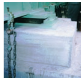
橋梁沓座モルタル
