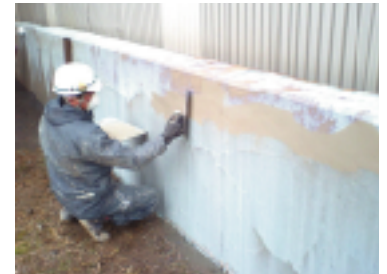
リフレモルセットTS 1回目塗布(下地調整)
