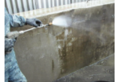
下地高圧洗浄
