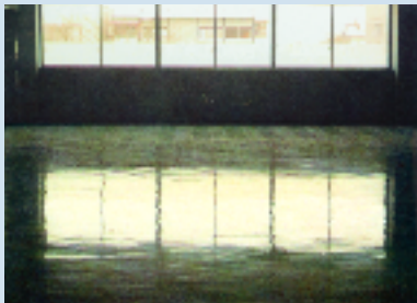
従来床(コンクリート直押え)施工例
