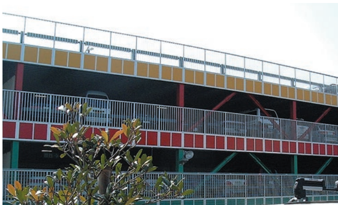
立体駐車場のスラブコンクリート
