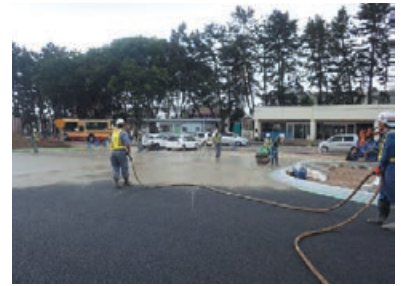
施工中（セメントミルクの散布・浸透）
