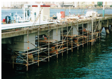
栈橋補修工事
