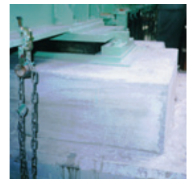
橋梁沓座モルタル
