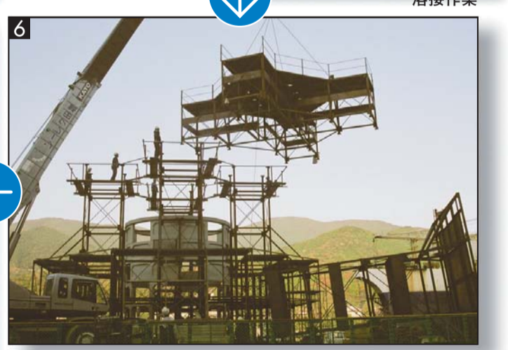
C部 (通称:ブリッジ) 架設状況
