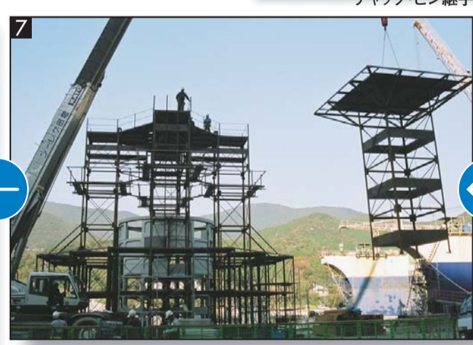
D部 (通称:ヘリポート) 架設状況
