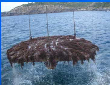
海藻バンク礁を台船上へ引き上げ
