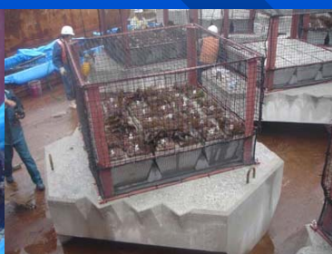
プレート取り付け完了
