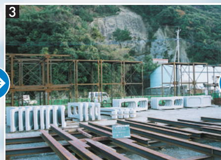
3 現場ヤードブロック仮置き
