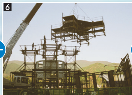
6 C部(通称:ブリッジ)架設状況
