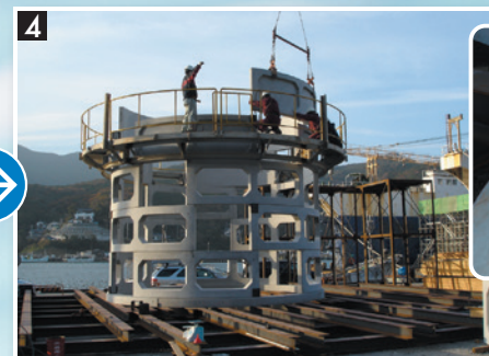
4 コンクリート部材組立
