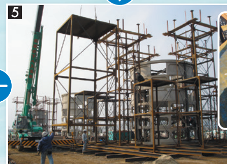
5 鋼製(Bブロック)組立状況
