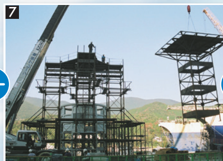
7 D部(通称:ヘリポート)架設状況
