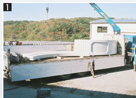
1 コンクリートブロック積込み
