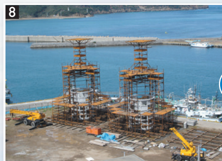
8 本溶接作業にて完成
