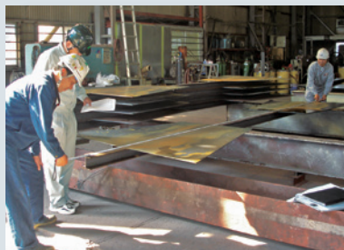
鋼製部材製作
