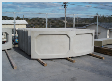
コンクリート部材製作
