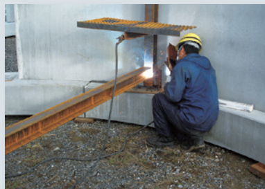
鋼製部材組立
