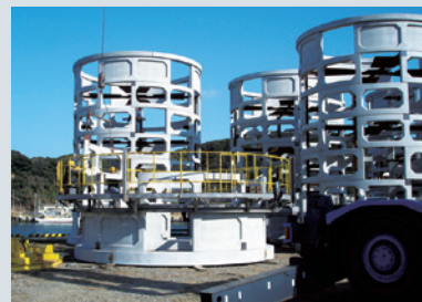
コンクリート部材組立
