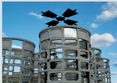
鋼製部材組立
