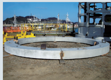
下端リング組立完了
