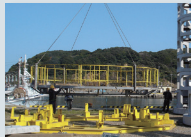
組立専用足場
