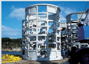
コンクリート部材組立完了
